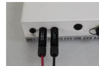
▲ Abbildung 4.12 Verbinden Sie die DC Stecker mit dem Wechselrichter
