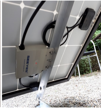
Abb. 07: An Profil C geschraubter Wechselrichter
