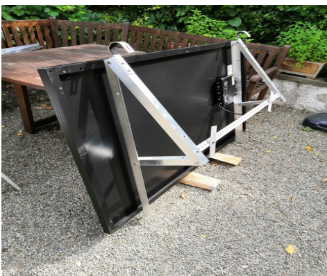
Abb. 04: Ansicht der Modulrückseite mit montierten Dreiecken, Edelstahlhaken und der Querschiene.
